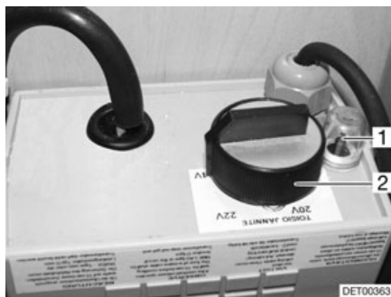
Afb. 190 Regelaar voor de elektrische vloerverwarming
