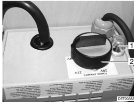
Afb. 129 Regelaar voor de elektrische vloerverwarming
