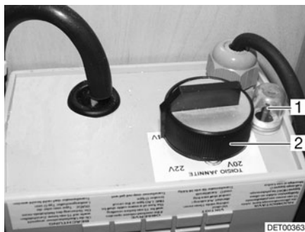
Afb. 126 Regelaar voor de elektrische vloerverwarming
